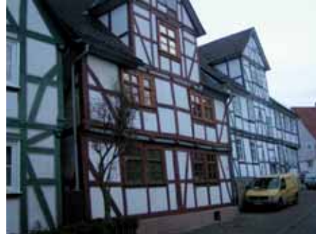
Sanierte Fachwerkhäuser in Kaufungen
