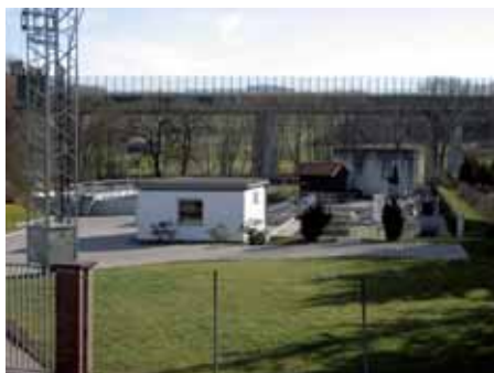
Kläranlage in Walburg
