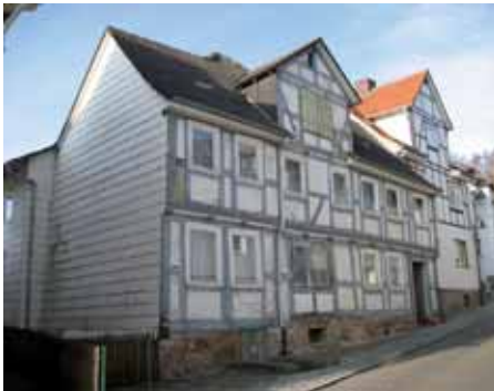
Fachwerkgebäude in der Altstadt
