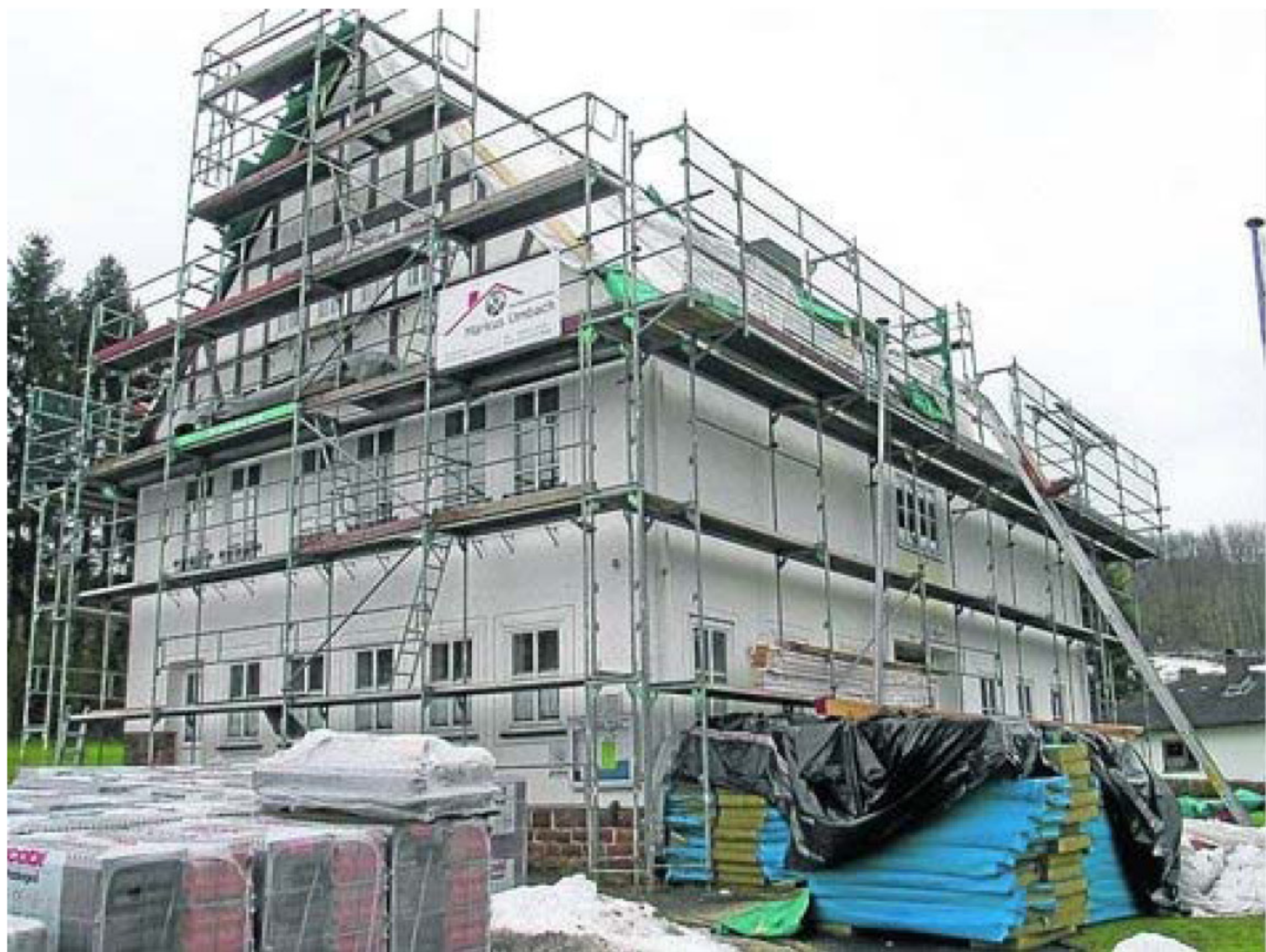
Keine Winterpause: Die Dachdecker erneuern zurzeit das Dach des Dorfgemeinschaftshauses in Wickenrode. Foto: Schindler
