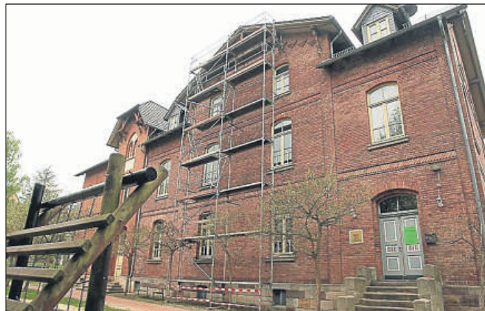
Gewandelt: Die unter Denkmalschutz stehende Rote Schule in Großalmerode wurde 2013 mit Fördermitteln des Stadtumbau Hessen in einen Kindergarten umgebaut.
