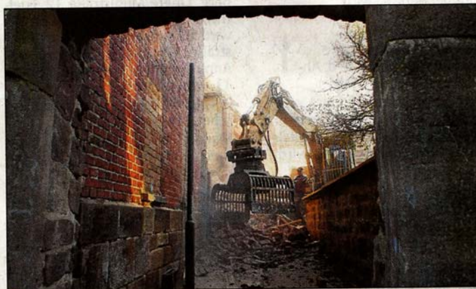
Abriss: Am Brauhaus 4 wird zurückgebaut, nur der Keller bleibt erhalten auf dem im Frühjahr 2012 ein Platz entsteht.
