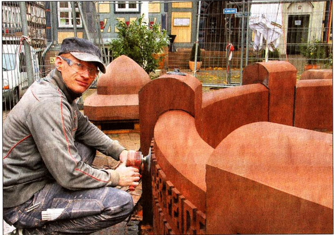
Runter mit dem Dreck: Steinmetz Bartosch Grabenhof von der Firma Gerloff aus Kassel, der fürs Foto die Maske abnahm, ist seit Tagen damit beschäftigt, die Oberfläche des Kanzler-Feige-Brunnens auf dem Lichtenauer Kirchplatz abzuschleifen und so von dunklen Ablagerungen zu befreien. Foto: Bretzler
